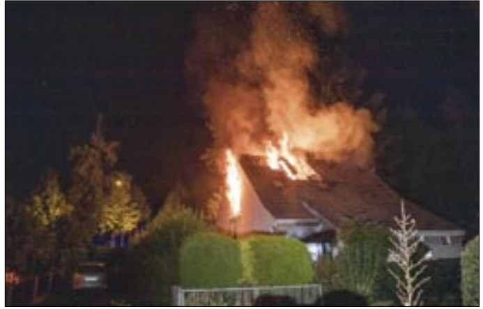
25.07.2019, FEU2Y, Harburg: Einfamilienhaus etwa 12 x 7 Meter in Vollbrand, eine Person im Gebäude vermisst. Einsatz von drei Trupps mit drei C-Rohren zur Menschenrettung wird aufgrund der Einsturzgefahr abgebrochen. Vier C-Rohre zur Brandbekämpfung im Außenangriff. Im weiteren Verlauf eine Brandleiche im Gebäude aufgefunden
