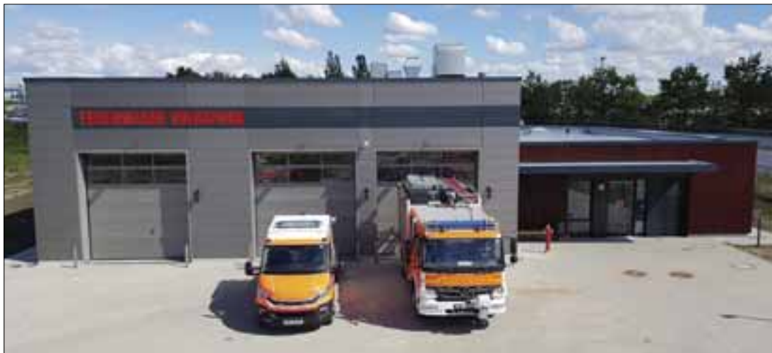
Feuerwache Volkspark: Der moderne und optimal gelegene Neubau erfüllt die Ansprüche, um den hohen Sicherheitsstandards der Elbtunnelabschnitte gerecht werden zu können
