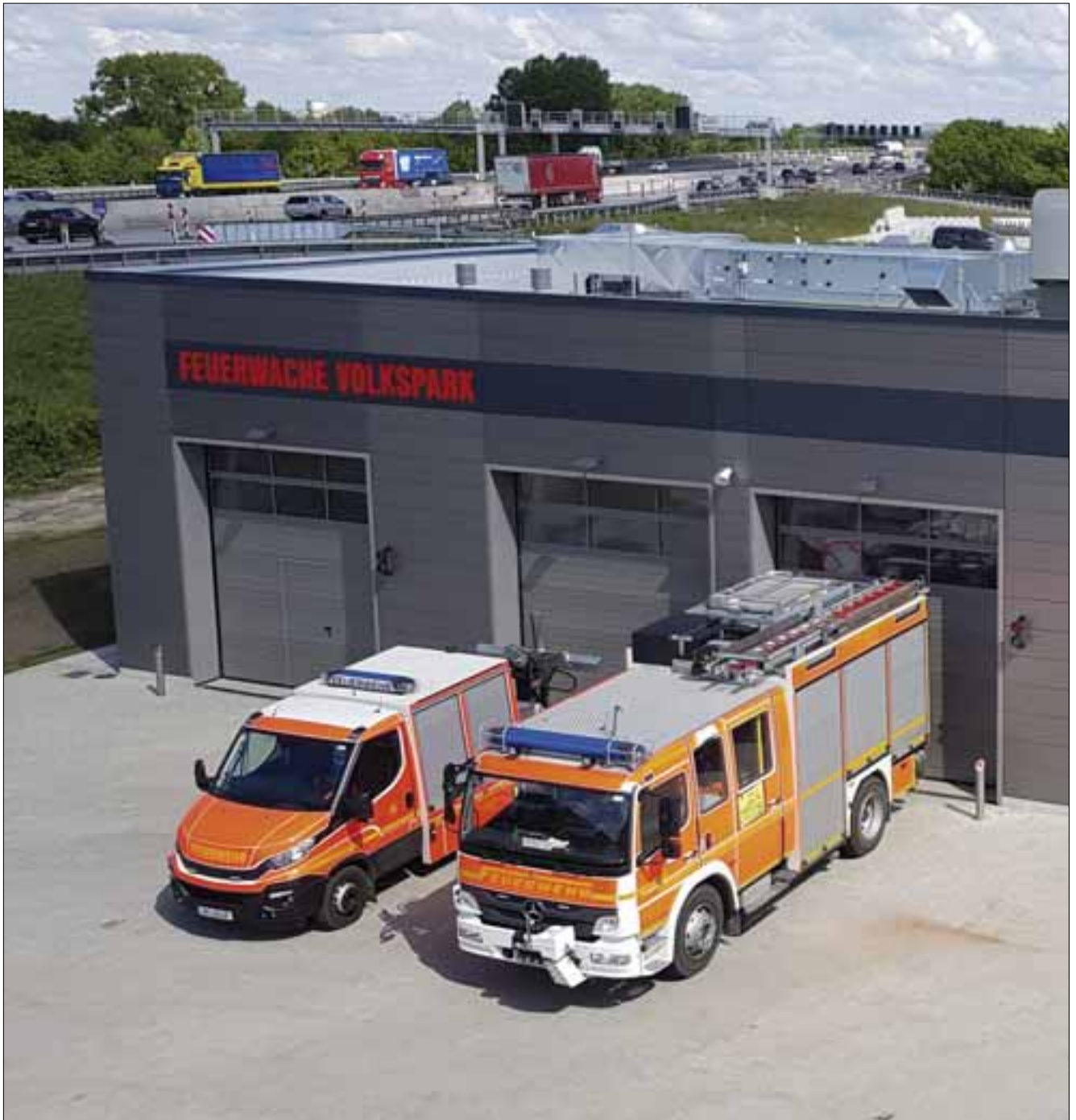
Feuerwache Volkspark: Der moderne Neubau erfüllt die Ansprüche, um den hohen Sicherheitsstandards der Elbtunnelabschnitte gerecht werden zu können und bietet den Einsatzkräften helle und ausreichend dimensionierte Arbeitsplätze_Seite 14
