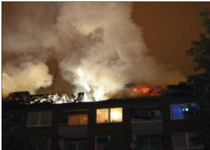
20.09.2016, FEU3, Wilhelmsburg: Dachstuhlbrand auf etwa 20 x 10 Meter, Brandbekämpfung mit einem Wenderohr von außen und vier C-Rohren im Innenangriff, 49 Bewohner evakuiert
