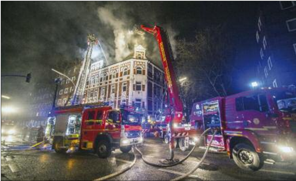
Dachstuhlbrand: Spektakulärer Einsatz in Wilhelmsburg, zwei gehbehinderte Personen aus Wohnungen gerettet, keine Person verletzt Seite 16
