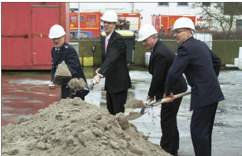
Wichtiges Projekt für die Aus- und Weiterbildung: Innensenator Michael Neuman (2.v.r.) und OBD Klaus Maurer (links) beim ersten Spatenstich zum Bau der neuen Brandsimulationsanlage
