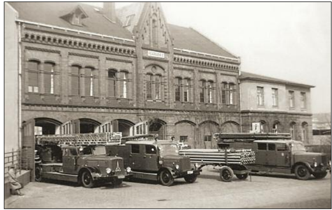
Gegen Ende des Zweiten Weltkrieges nahezu völlig zerstört: Die instandgesetzte Feuerwache 2 in der Mörkenstraße Anfang der 1950er Jahre
