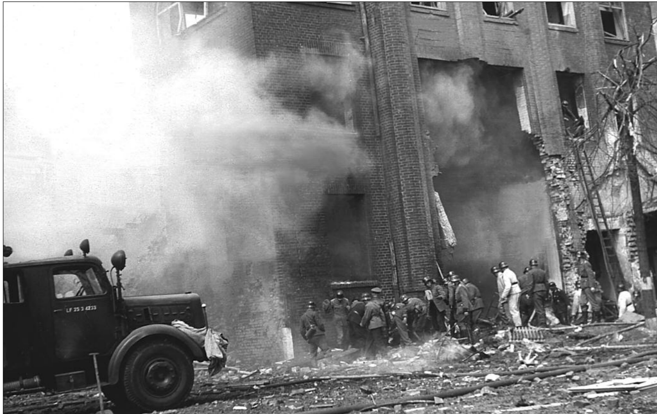
Davongekommen: Auch die Hauptfeuerwache am Berliner Tor blieb nicht verschont, die Schäden hielten sich jedoch in Grenzen
