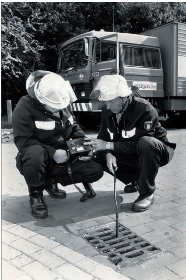
1986: Einsatzkräfte kontrollieren nach einem Erdgasaustritt die Kanalisation
