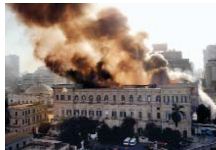
Brand im Parlamentsgebäude in Kairo: Wassermangel verhinderte effektive Löscharbeiten
