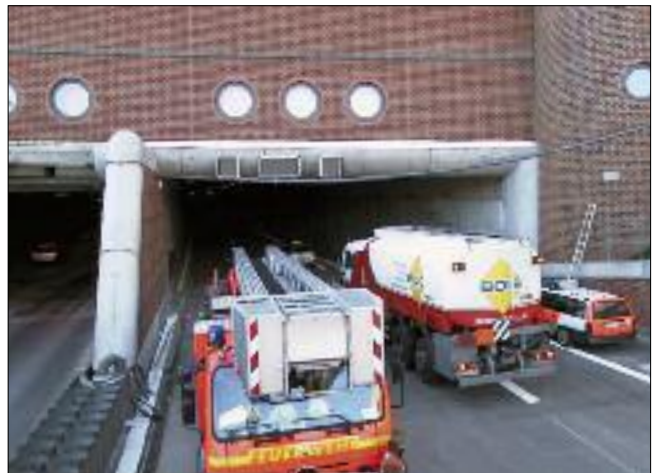
Einsatz im Elbtunnel: Mit neuer Organisationsstruktur zur Entlastung der Mitarbeiterinnen und Mitarbeiter
