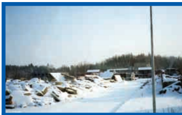
Zerstörte Gebäude wie nach einer Explosion bzw. einem Bombenangriff.
