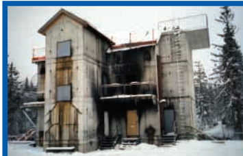
Ein Brandsimulationsgebäude an der LFS in Rosersberg.
