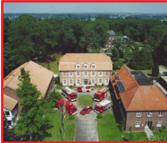
Die LFS Loy: Eindruck von oben – Feuerwehr-Kompetenzzentrum mit allem Drum und allem Dran. Richtig.
