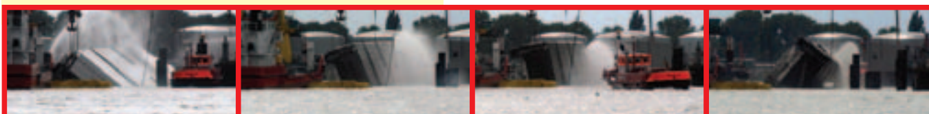
Der kritische Moment: Die ENA II wird mithilfe des aus Bremerhaven angeforderten Schwimmkrans Enak gedreht – ein Auseinanderbrechen droht.
