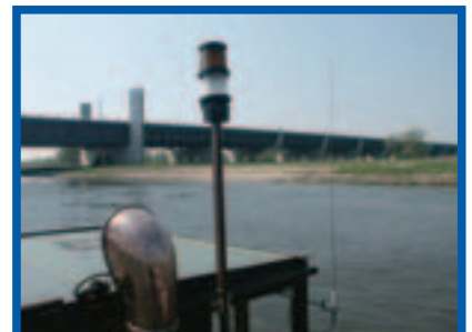
Im Stahltrog über die Elbe: Seit knapp einem Jahr verbindet die größte Kanalbrücke Europas den Mittellandkanal im Westen mit dem nach Berlin führenden Elbe-Havel-Kanal.
