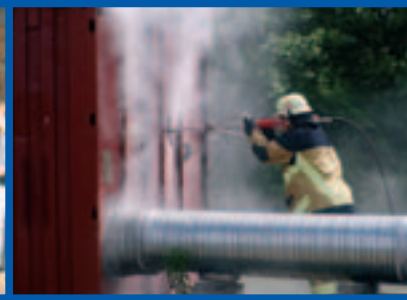
Widerstand zwecklos: Wenn das Strahlmittel Granulat dem Löschwasser beigemischt wird, lassen sich Räume durch geschlossene Wandmaterialien herunterkühlen und ablöschen . Eine revolutionäre Neuentwicklung.
