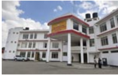
Der Neubau der Feuerwache Temeke bietet Platz für Material von Tauchern, Höhenrettern und für Atemschutz.
